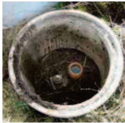
Mehr als 100 solcher Unterflur-Hydranten installierten die Landwirte im Pumpbezirk Trabuhn mit viel Eigenleistung.
